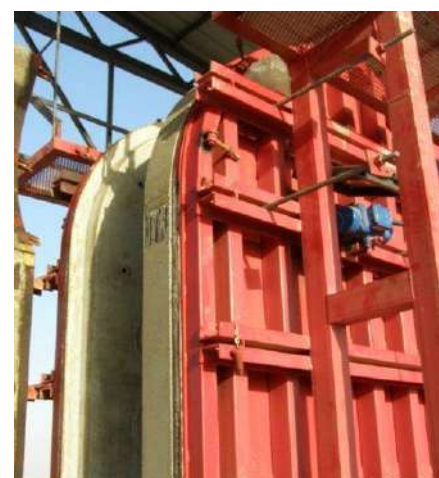
Stade Al Anbar / IRAK Mur de soutènement
